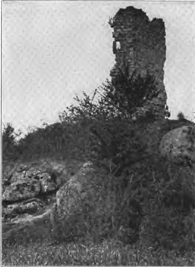
Fig. 128. Siegenstein. Ansicht der Burgruine, Südseite, von außen.
